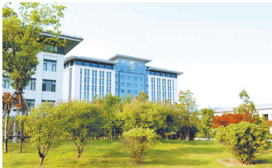
图为淮北市委党校综合楼侧景
